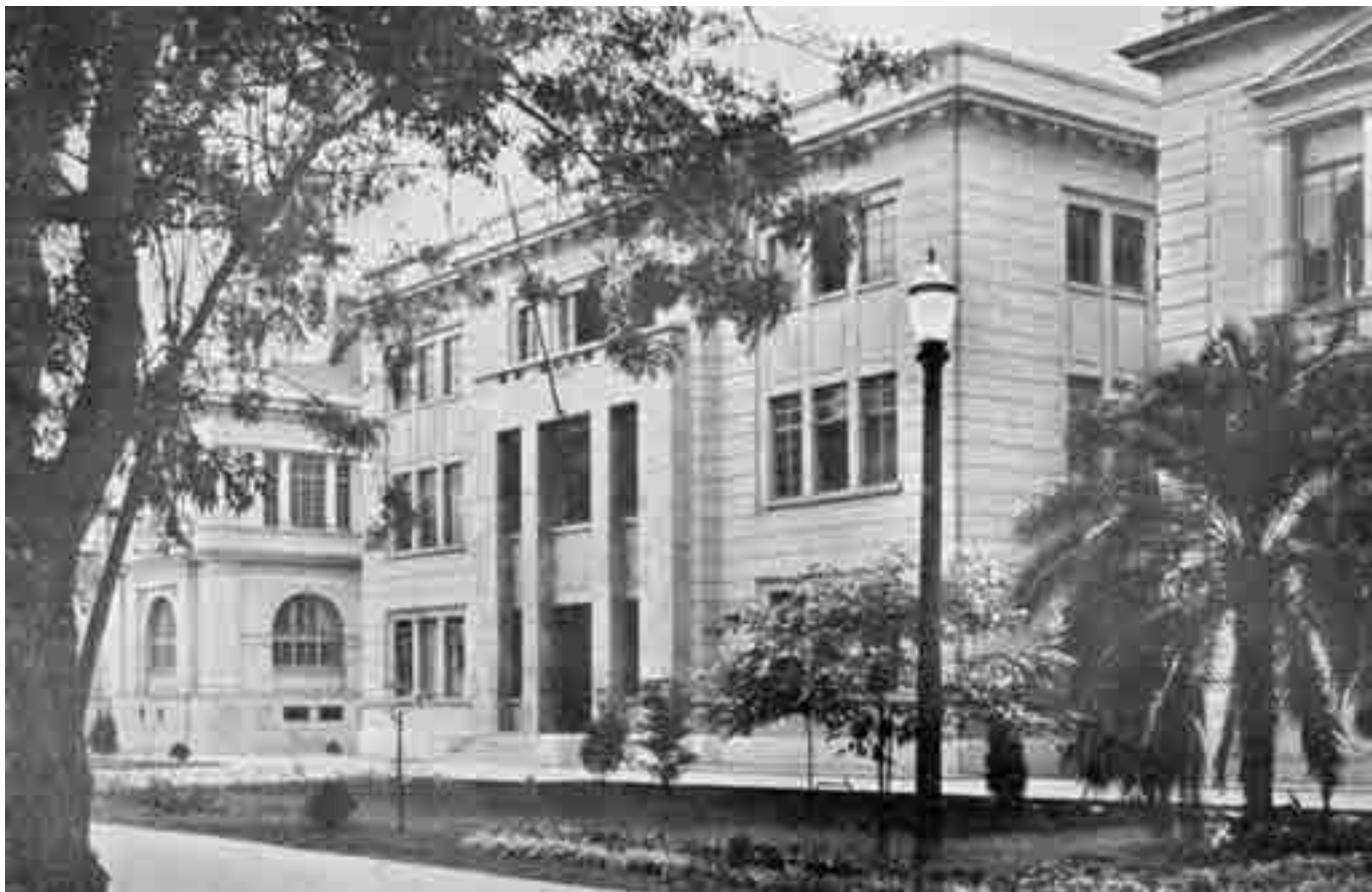
Prédio do Laboratório de Ensaio de Materiais – LEM, depois IPT, ao lado da Escola Politécnica, no bairro do Bom Retiro, em São Paulo
