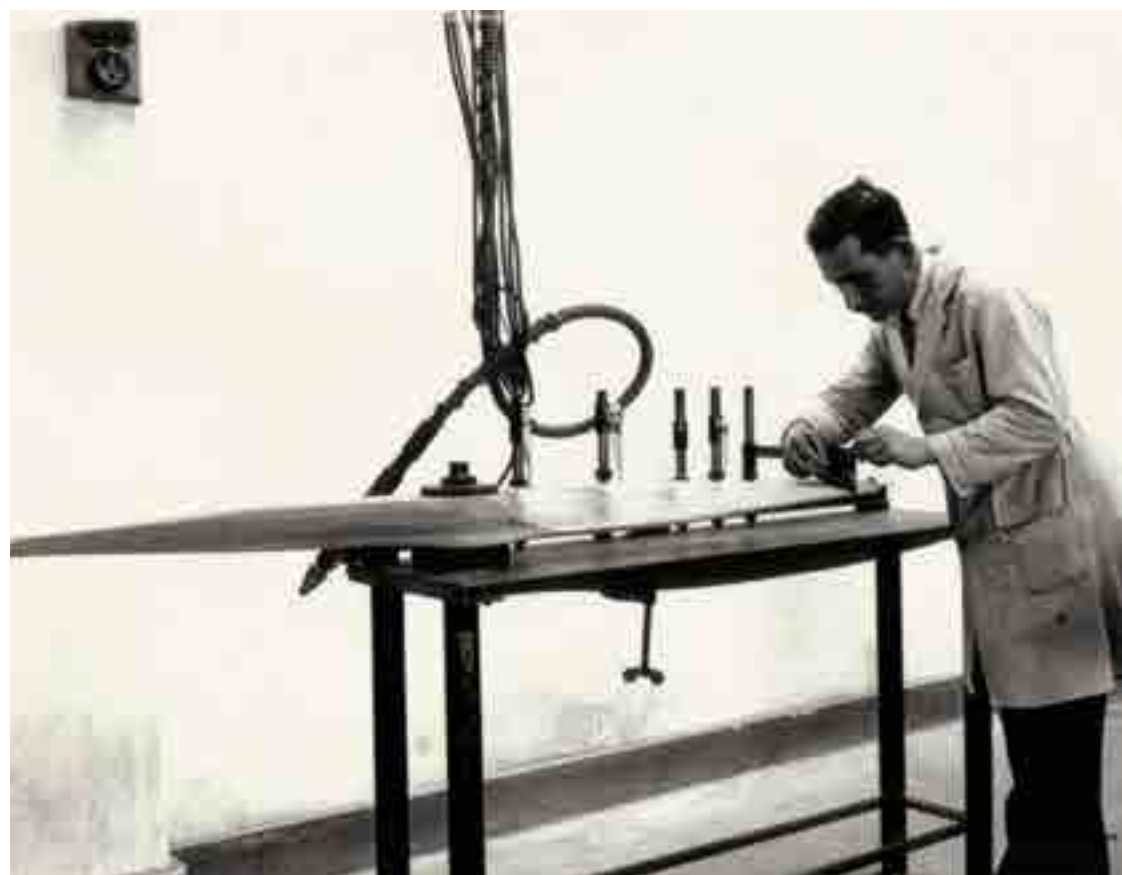
O projeto e a fabricação de hélices começaram na Seção de Madeiras em 1936; em 12 anos a Seção de Madeiras e Aeronáutica fabricou 1.513 hélices para a aviação militar e civil
