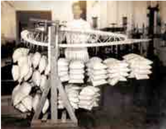
Ensaio de nervura, teste de esforço e teste de tração do Planalto, o CAP-1, que teve dez unidades fabricadas pela Companhia Aeronáutica Paulista na década de 1940
