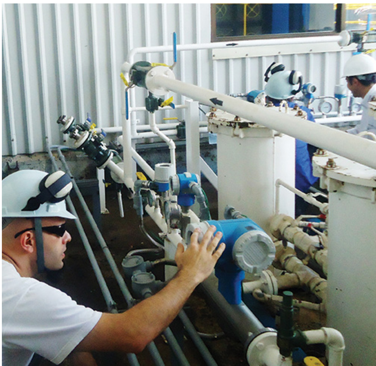
Figura 3.5.6. Imagem da validação dos resultados da instalação e da avaliação da confiabilidade metrológica dos sistemas de medição instalados em plantas termoeletricas de propriedade do Instituto Costarricense de Electricidad (9, p.63) .
