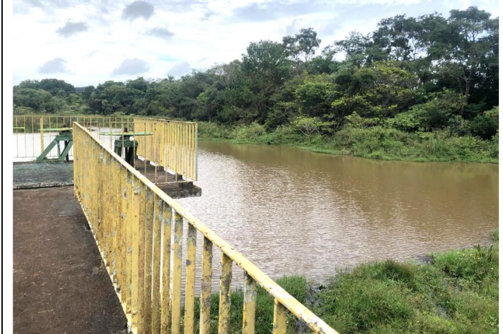
Reservatório Mandacaru no rio Pardo, a nove quilômetros a jusante da represa em construção.
