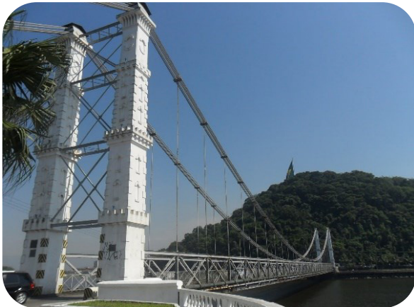
Figura 22 – Vista diurna da Ponte Pênsil em São Vicente – SP.
