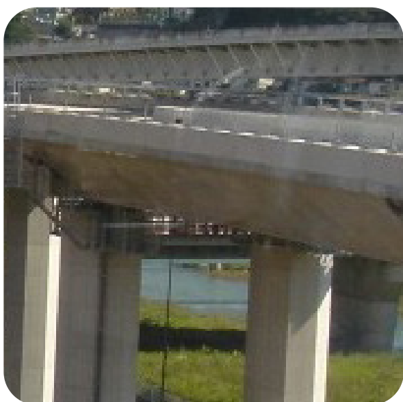
Figura 65 – Detalhe da plataforma instalada na região de junta, indicada na seta 2 da Figura 63.
