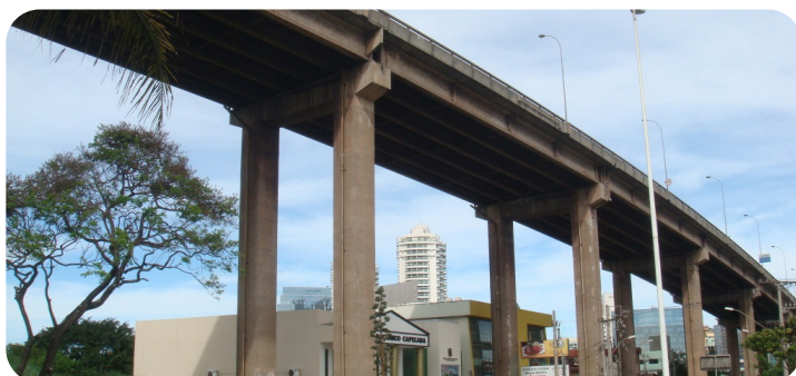
Figura 16 – Ponte de concreto protendido construída com vigas isostáticas. Observa-se a presença de juntas de dilatação em todos os apoios das vigas.
