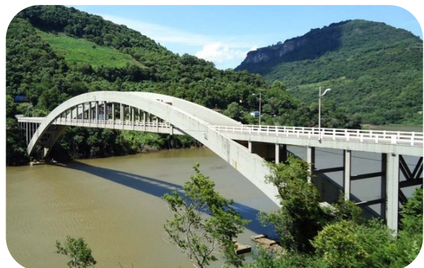
Figura 20 – Ponte com o tabuleiro posicionado na seção intermediária do arco.
