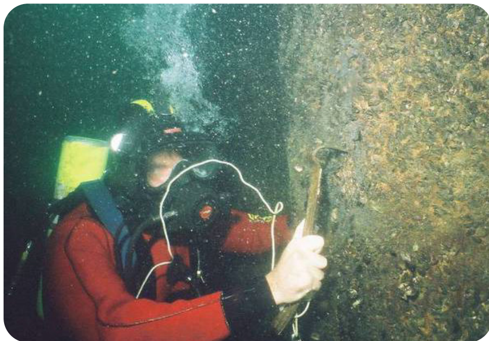
Figura 172 – Espátula utilizada para limpeza da superfície inspecionada.
