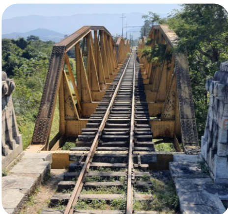
Figura 3 – Ponte ferroviária treliçada em estruturas metálicas.
