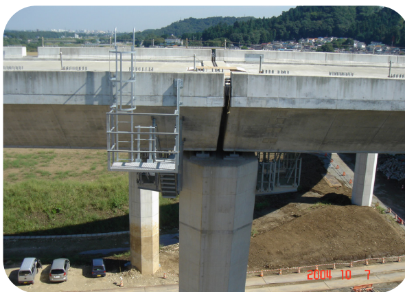
Figura 64 – Detalhe da plataforma instalada na região de junta, indicada na seta 1 da Figura 63 – Note-se que as plataformas estão instaladas em ambos os lados.
