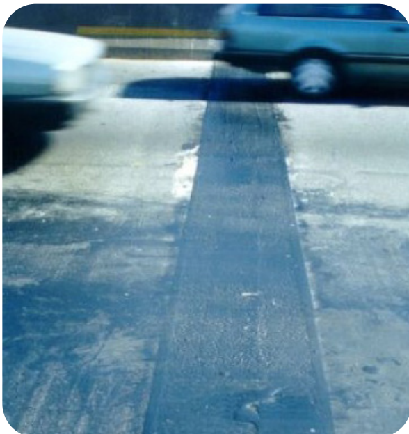
Figura 113 – Junta de dilatação utilizando material asfáltico.
