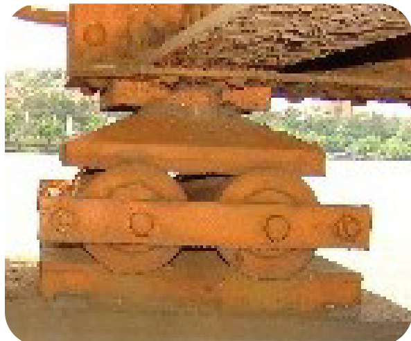
Figura 94 – Aparelho de apoio móvel - Permite movimento de translação no sentido longitudinal da ponte
