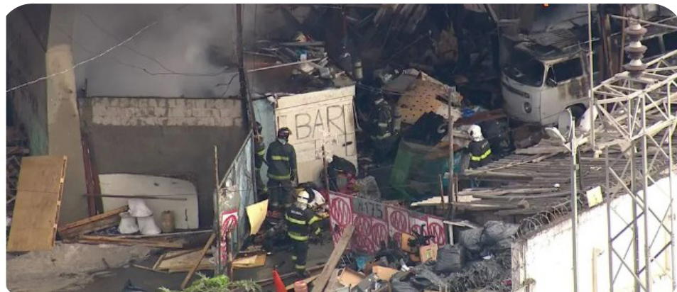
Figura 87 – Vista da região inferior da ponte do Jaguaré, mostrada na Figura 86, após o incêndio.
