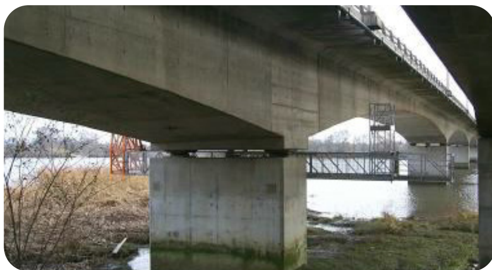
Figura 80 – Vista geral da The Bellevue Bridge, Reino Unido, em 2013.
