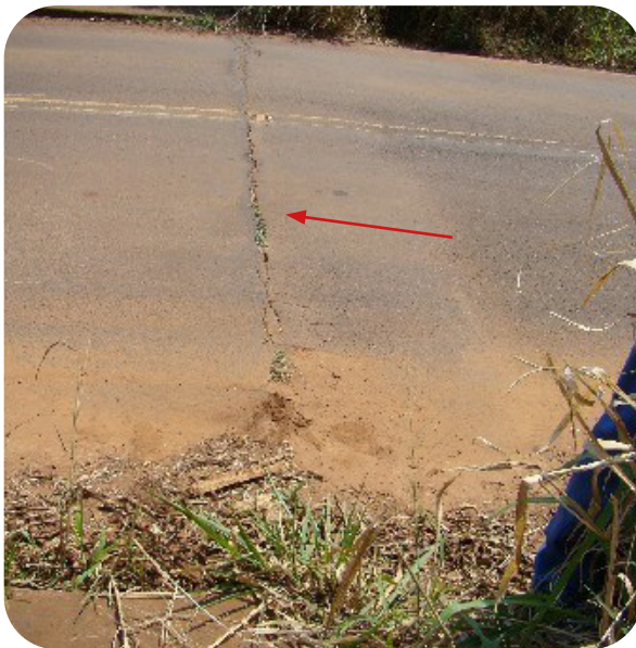
Figura 122 – Junta de dilatação coberta com asfalto.
