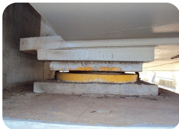
Figura 100 – Imagem de aparelho de apoio deslizante instalado sob a viga metálica de ponte
