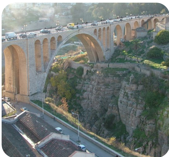
Figura 154 – Vista geral do vale profundo no qual se insere a ponte em arco (cidade de Constantine, Argélia). Atentar para a característica do maciço rochoso exposto.
