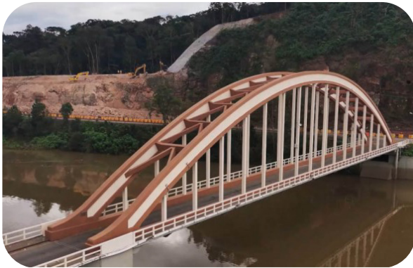
Figura 21 – Ponte com tabuleiro posicionado sob o arco.
