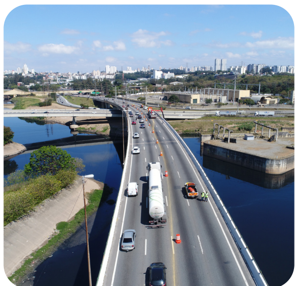
Figura 56 – Outra imagem de caminhão utilizado para inspeção, com interdição de duas faixas de rolamento.
