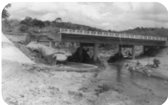
Figura 71 – Ruptura do aterro de acesso em ponte no ano de 1990, com consequente desabamento da laje de transição. Notar a presença de material retido junto aos pilares.
