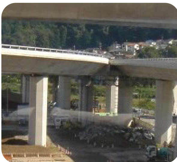
Figura 66 – Detalhe da plataforma instalada na região de encontro das superestruturas, indicada na seta 3 da Figura 63.
