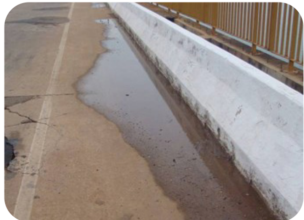
Figura 125 – Acúmulo de água na região próxima aos guarda rodas laterais e ausência de tubulação de drenagem (buzinotes).
