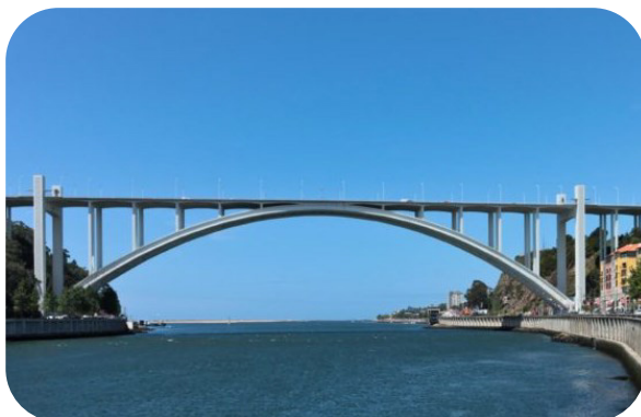
Figura 19 – Ponte com tabuleiro posicionado sobre arco.
