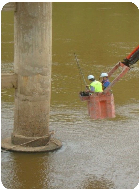
Figura 158 – Inspeção especial da infraestrutura de uma ponte no município de Iporanga, SP, usando cestos.
