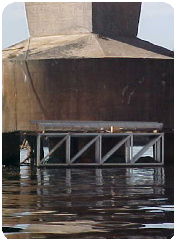
Figura 159 – Montagem de plataforma flutuante para inspeção especial de elementos de fundação no Complexo do Cebolão, em São Paulo, SP.
