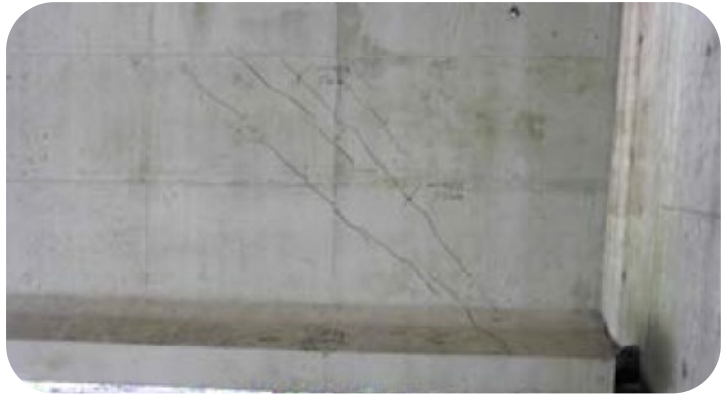
Figura 151 – Fissuras de cisalhamento.
