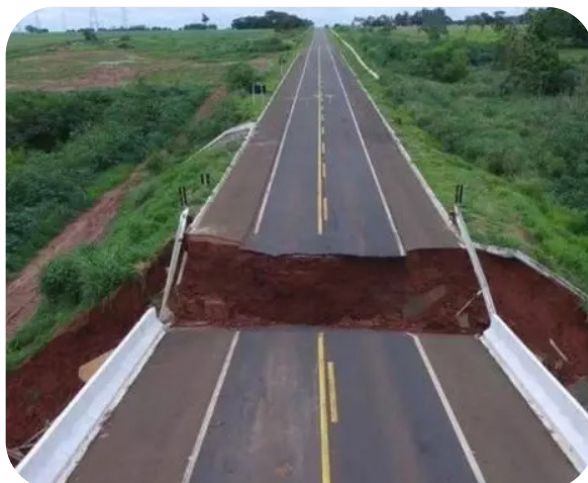
Figura 85 – Boçoroca de evolução acelerada destrói ponte.
