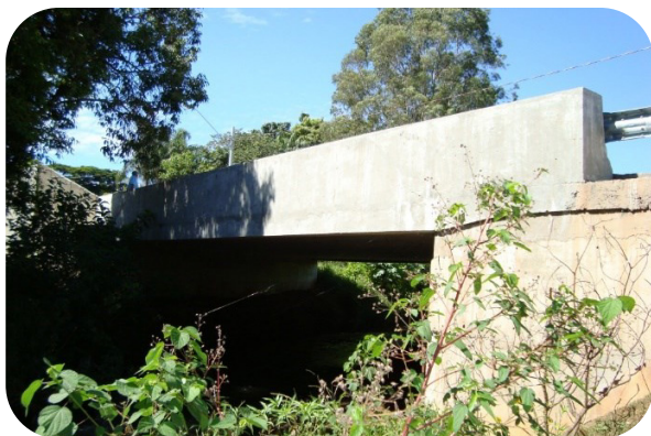
Figura 146 – Vista lateral da ponte esconsa.
