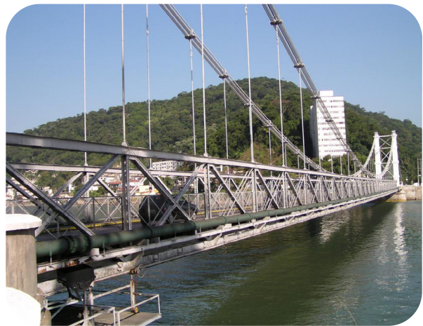
Figura 61 – Outra vista da ponte. A seta indica a plataforma móvel para inspeção e manutenção, instalada sob a ponte.
