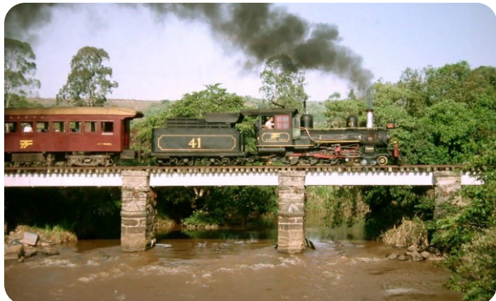
Figura 4 – Ponte ferroviária sobre vigas.
