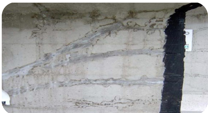
Figura 153 – Fissuras provocadas por protensão na região das ancoragens.
