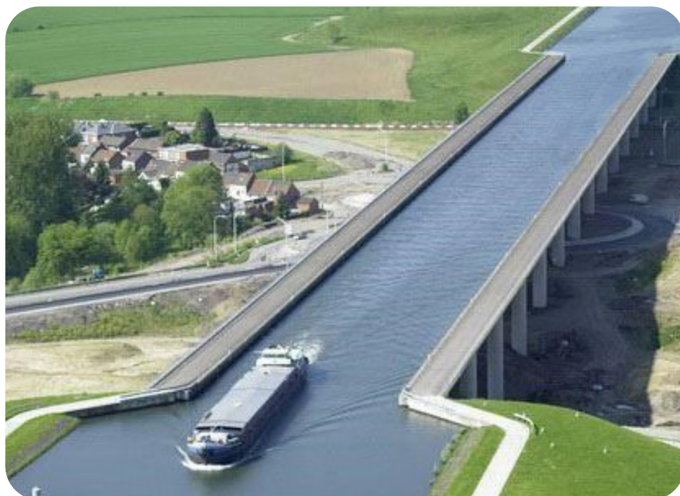
Figura 6 – Ponte canal para condução de embarcações.
