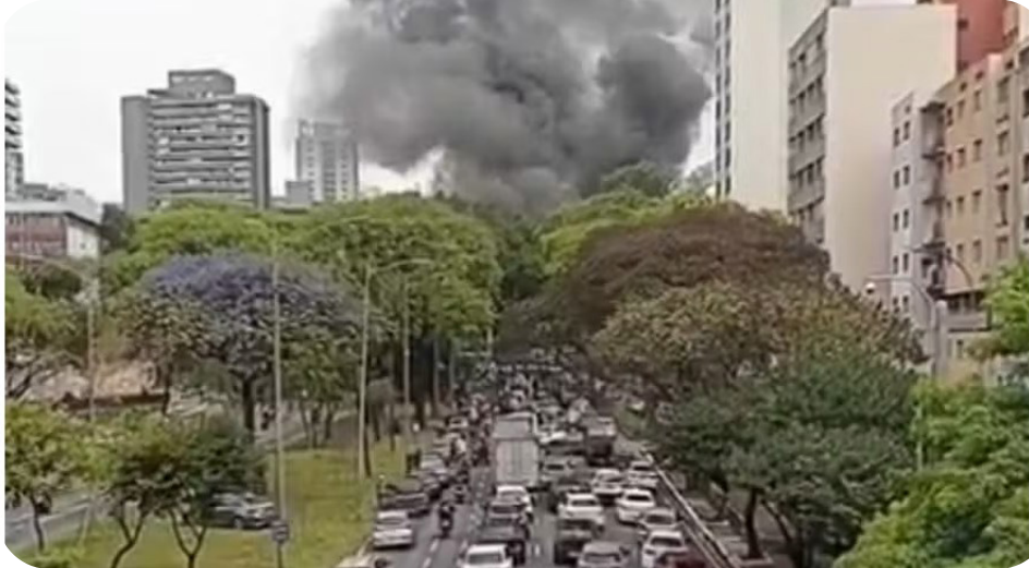
Figura 88 – Incêndio na região inferior do Viaduto Condessa de São Joaquim em São Paulo. Segundo informações da mídia, o incêndio teria começado em pertencentes de moradores em situação de rua.
