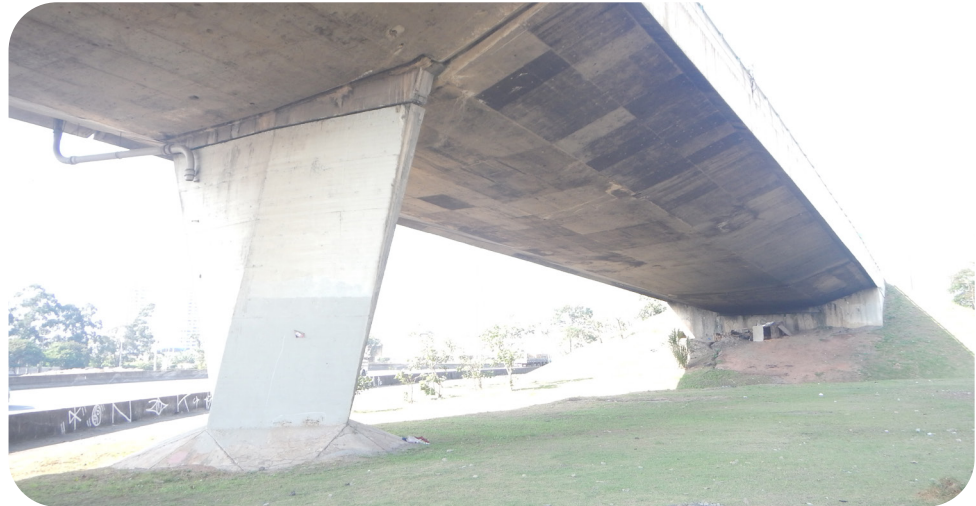
Figura 18 – Sistema estrutural com seção caixão.
