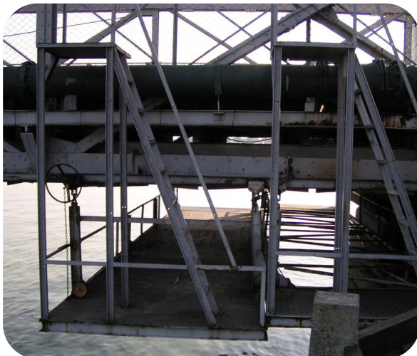
Figura 62 – Detalhe da plataforma móvel para Inspeção e manutenção dos elementos do tabuleiro da Ponte Pênsil.
