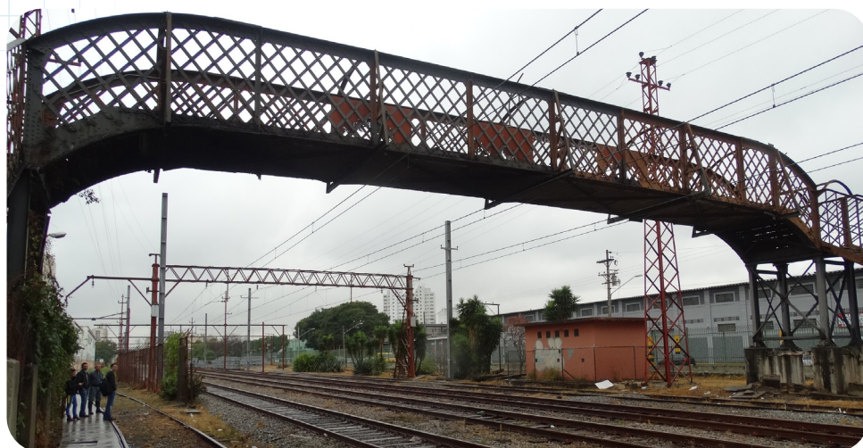
Figura 5 – Passarela de pedestres em estruturas metálicas.
