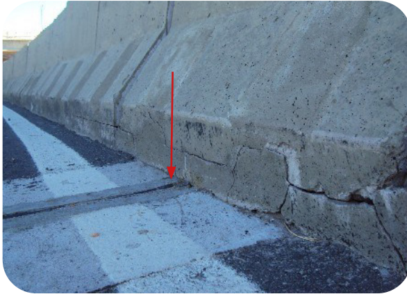
Figura 120 – Barreira rígida (guarda rodas) instalada sobre a junta de dilatação.
