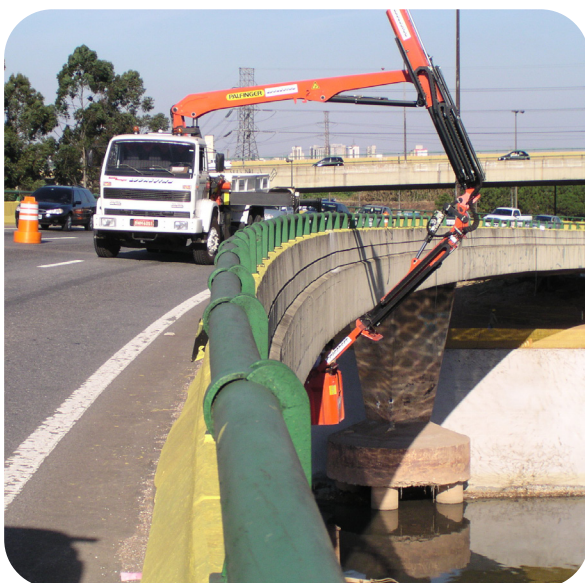
Figura 55 – Inspeção realizada em ponte com auxílio de caminhão com braço articulado – Necessidade de interdição de 2 faixas de rolamento para posicionamento do caminhão.
