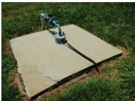
**Foto 6** – Poço no município de Tabapuã (P11) denotando altura do tubo de boca inadequada
