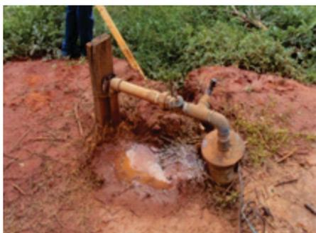
**Foto 9** – Poço no município de Potirendaba (P14) denotando ausência de laje de proteção.
