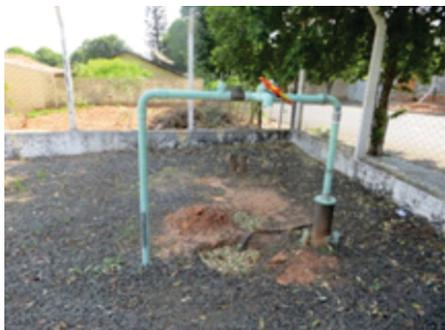
**Foto 5** – Poço no município de Oriente (P8) denotando ausência de laje de proteção.
