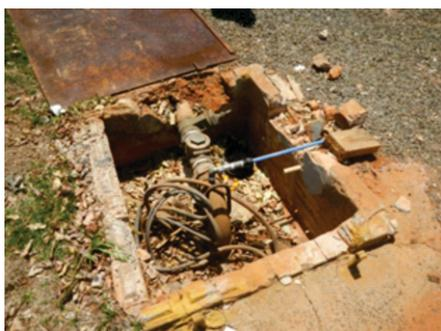
**Foto 15** – Poço no município de Glicério (P1) denotando tubo de boca abaixo da superfície do terreno.
