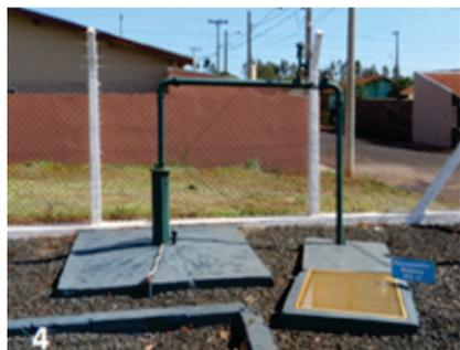
**Fotos 1 a 4** – Poços denotando boas condições de proteção sanitária. 1. Flórida Paulista (P1), 2. Santana da Ponte Pensa (P2), 3. Nhandeara (P10) e 4. Mira Estrela (P13).
