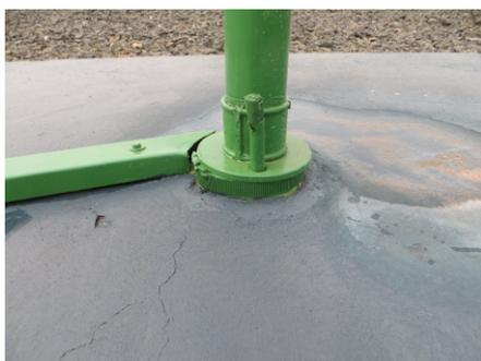
**Foto 14** – Poço no município de Magda (P9) denotando tubo de boca com altura inadequada.
