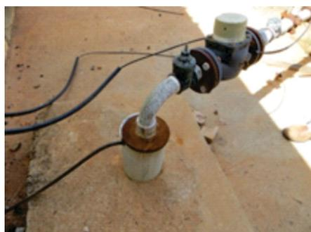
**Foto 12** – Poço no município de Taiapu (P4) denotando vedação inadequada do poço.
