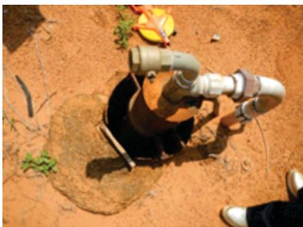
**Foto 8** – Poço no município de Cafelândia (P8) denotando ausência de cimentação sanitária.
