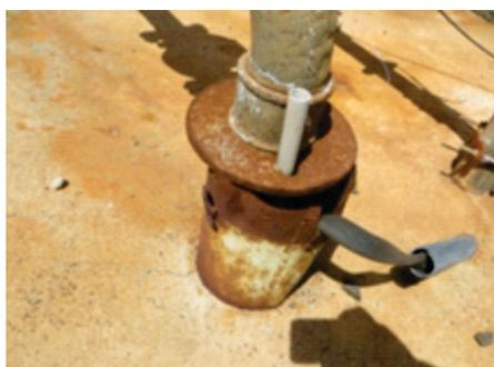
**Foto 11** – Poço no município de Taiapu (P5) denotando vedação inadequada do poço.
