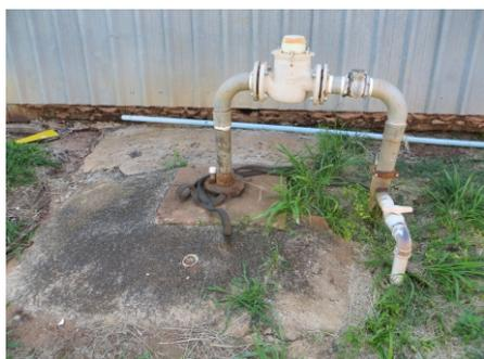
**Foto 13** – Poço no município de Ariranha (P9) denotando tubo de boca com altura inadequada.
