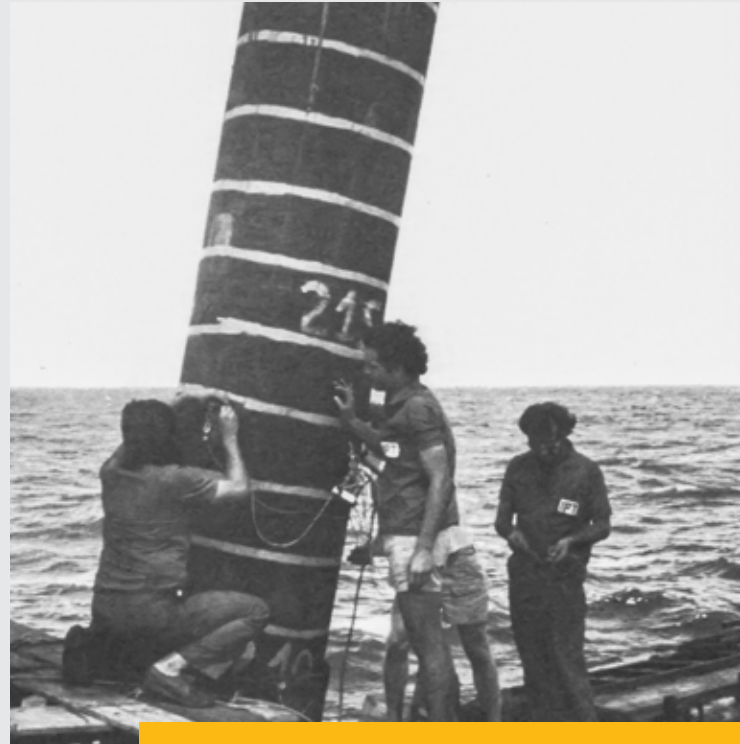
Cravação de estacas em águas marítimas profundas. Fonte: Arquivo IPT.
