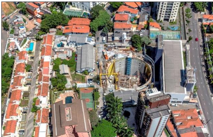
Figura 4. Dificuldade de espaço para implantação das obras Fonte: Metrô de SP (2023)
