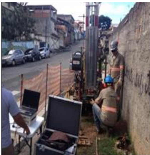
Figura 5. Sondagens geotécnicas. Fonte: Metrô de SP (2023)
