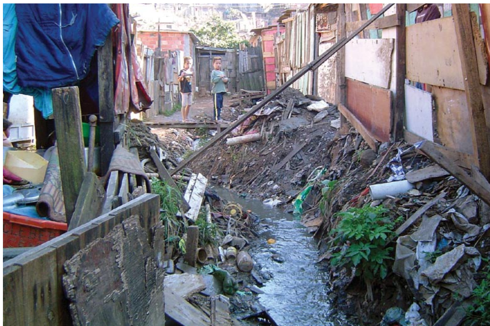
Figura 4 – Área insalubre em ocupação de baixa renda no município de Osasco, SP, com poluição do solo e da água, por falta de saneamento básico, com alto risco à saúde da população, constituindo, também, área de risco a escorregamento e inundação – Foto Nurg/IPT
