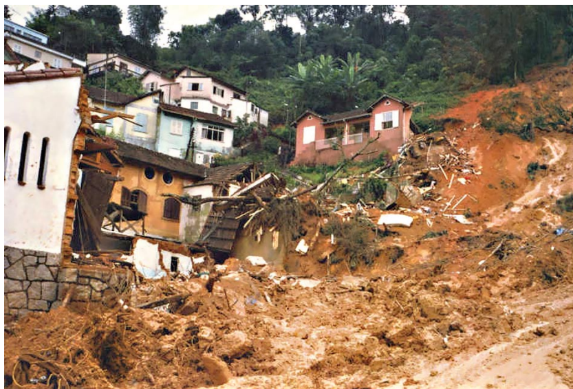
Figura 3 – Área de risco no município de Blumenau, SC, envolvendo população de alto poder aquisitivo – Foto Nurg/IPT
