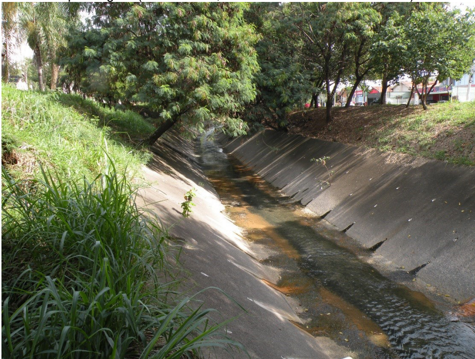
Figura 20 – Afluente do rio Capivari onde a planície aluvial foi urbanizada, com aterramento, canalização, arruamento e construção de casas, dificultando a delimitação e identificação pedológica. (Ponto CA-01, Coord. UTM: 289.032/7.462.865)
