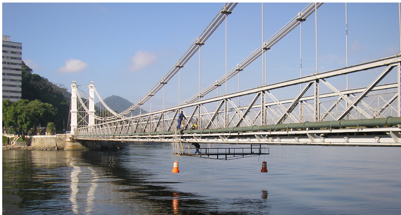
Inspeções na ponte pênsil de São Vicente
