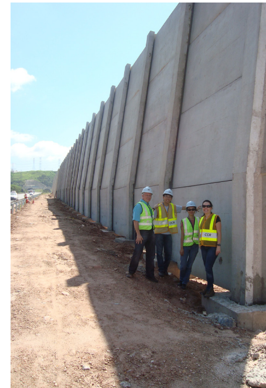
Barreiras em instalação no Rodoanel, próximo ao Tamboré
