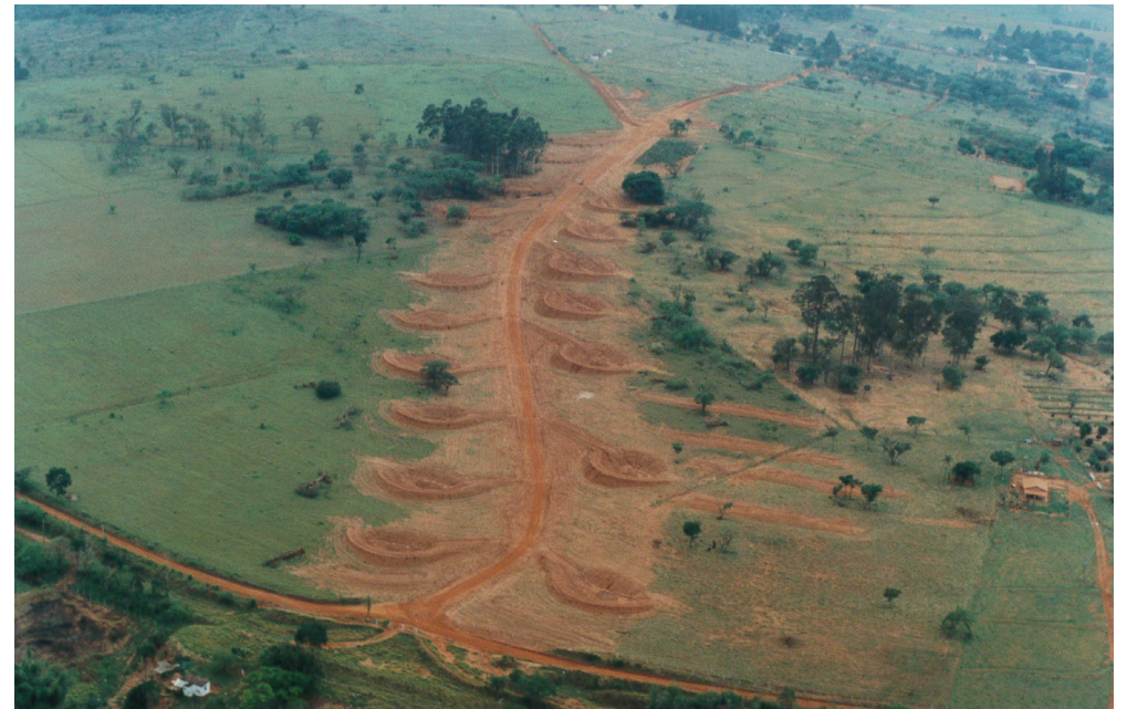
Controle do escoamento das águas pluviais em estrada não pavimentada
