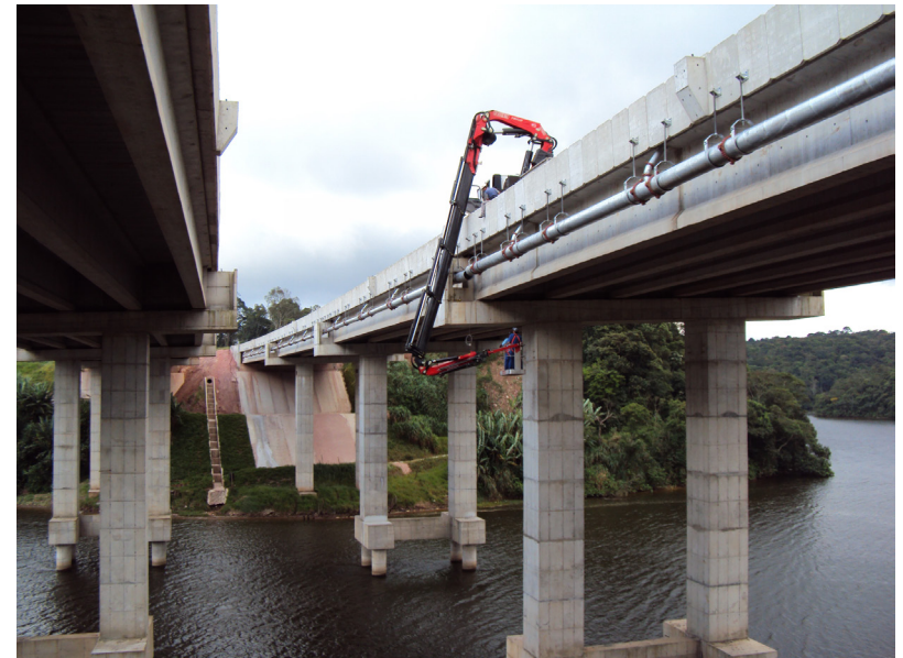
Inspeção em obra de arte do Rodoanel
