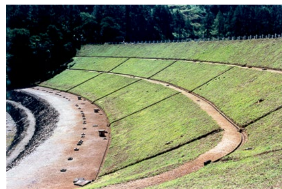
Inspeções na Barragem Paiva Castro para a Sabesp
